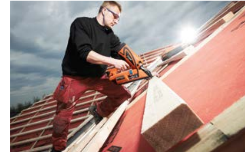
Krycie dachu – łaty, kontrłaty
