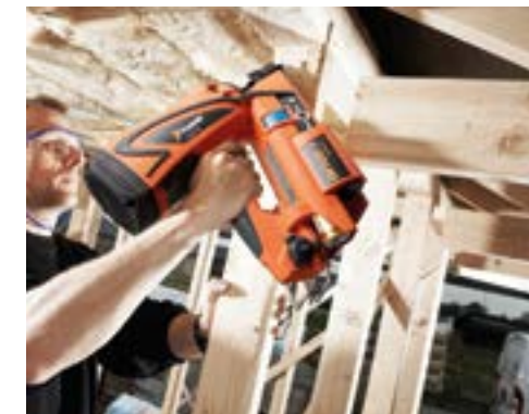
Montaż konstrukcji ramowych drewnianych
